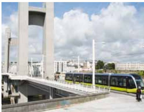
Brest : 22 e ville équipée d'un tramway
